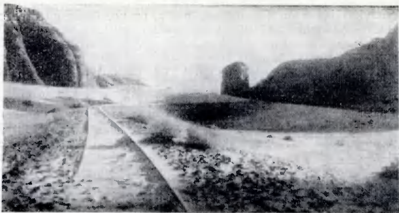
Рис. 2. Участок недействующей Хиджазской железной дороги
